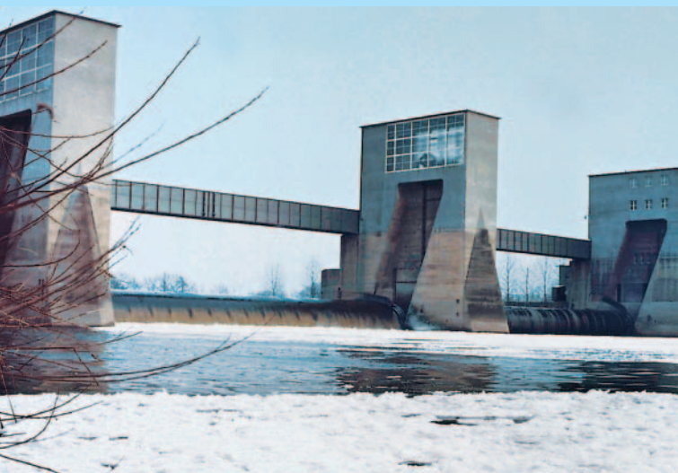
Ende der 1950er Jahre: Auf Flüssen bildet sich Schaum – hervorgerufen durch Waschmittel-Tenside im Abwasser.
